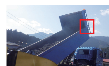
温度計により荷台の合材温度を測定
