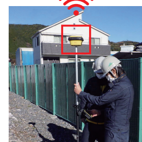
GNSS受信機による測量
