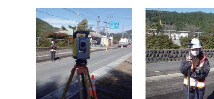
TS (トータルステーション) 測定
