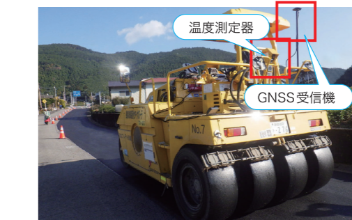
温度測定器 GNSS受信機 転圧温度管理システム表示 温度測定表示
