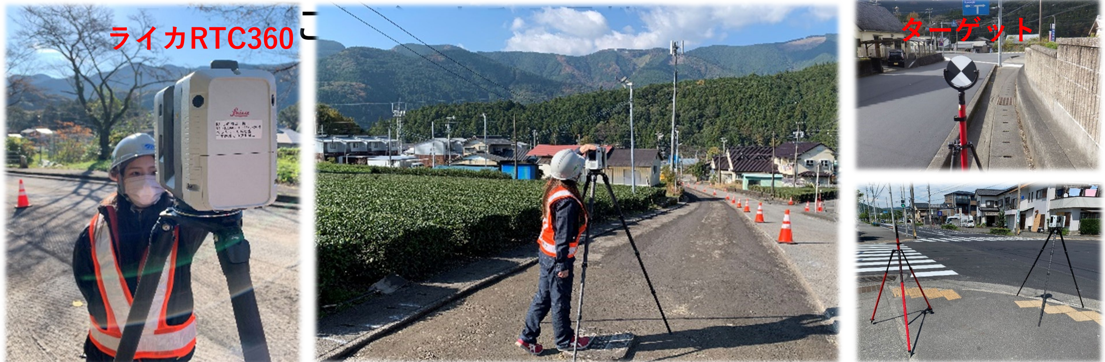
地上型レーザースキャナー測量 実施状況
