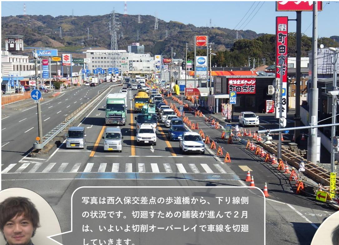
写真は西久保交差点の歩道橋から、下り線側の状況です。切廻すための舗装が進んで2月は、いよいよ切削オーバーレイで車線を切廻していきます。
